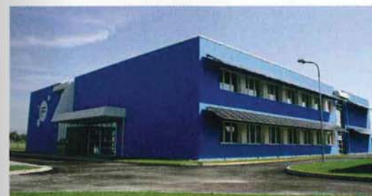
I nuovi edifici della sede di Friuli Innovazione
